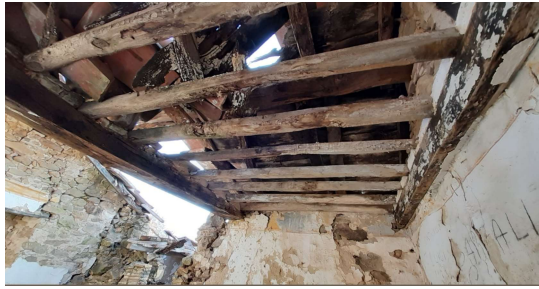
Foto 1: Sottotetto del vano centrale
